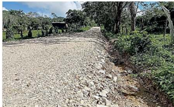
Fotografía: I0209.- Rehabilitación de revestimiento en el Municipio de Macuspana, Ra. Santuario 2da sección (tramos aislados).
