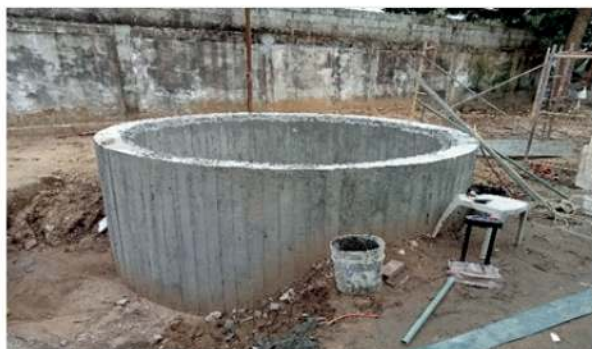
Fotografía: I0158.- Rehabilitación de cárcamo sanitario en el Municipio de Macuspana, en la Ra. San Antonio.
