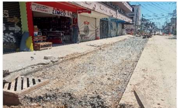
Fotografía: I0170.- Construcción de drenaje pluvial en el Municipio de Macuspana, en la ciudad de Macuspana, en las calles Anáhuac y av. Alatorre, en tramos aislados, entre las calles av. Carlos Pellicer Cámara y 20 de Noviembre de la colonia Centro.
