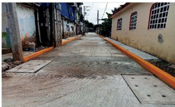
Fotografía: I0178.- Construcción de pavimento en el Municipio de Macuspana, Ciudad de Macuspana, en la calle cerrada 21 de Marzo de la colonia Independencia.
