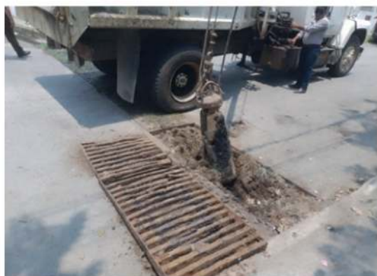
Fotografía: Limpieza de colector principal con tubería de 8" con camión tipo Vactor, Se trabajan 150 metros lineales de esta tubería.
