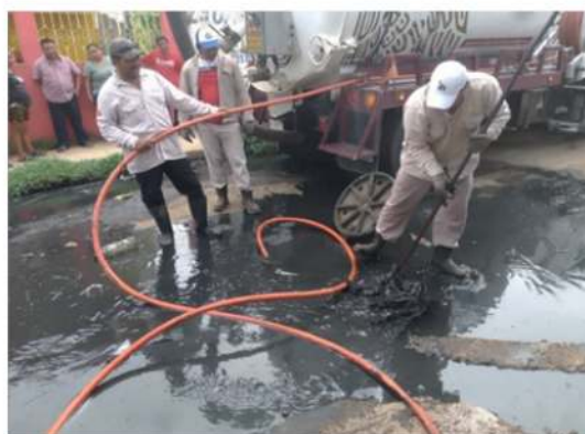
Fotografía: Limpieza de colector principal con tubería de 8" con camión tipo Vactor, Se trabajan 150 metros lineales de esta tubería.
