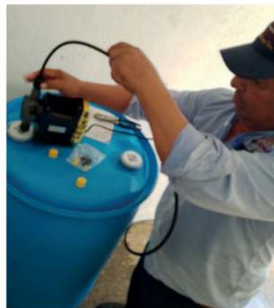
Fotografía: Entrega e instalación de bomba dosificadora en el Poblado Aquiles Serdán (San Fernando).
