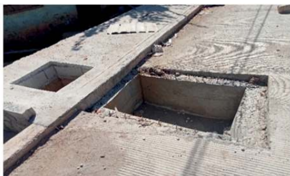
Fotografía: I0157.- Construcción de guarniciones y banquetas en el Municipio de Macuspana, Villa Benito Juárez, colonia Manuel Vargas Ramírez en la calle Santa teresa entre las calles 1ra de Mayo y Circunvalación Sur.
