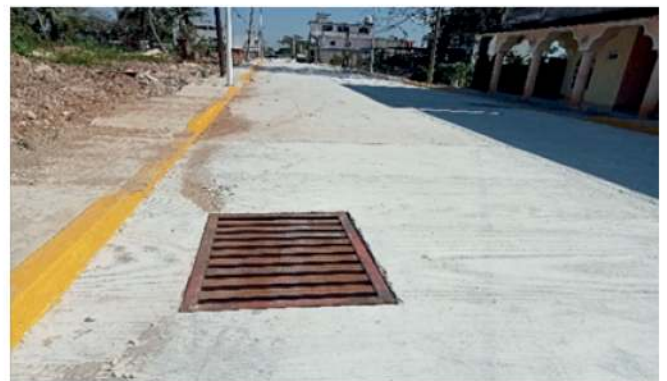
Fotografía: Construcción de pavimento con concreto hidráulico en el Municipio de Macuspana, Fraccionamiento Primavera, calle cerrada de Azucena.
