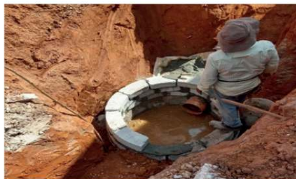
Fotografía: I0170.- Construcción de drenaje sanitario en el Municipio de Macuspana, calle 5 de Mayo entre las calles 27 de Febrero y calle Porfirio Díaz, de la colonia Manuel Vargas Ramírez.
