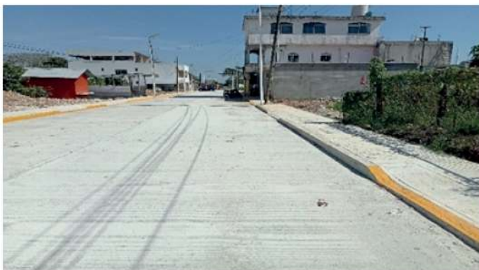
Fotografía: Construcción de pavimento con concreto hidráulico en el Municipio de Macuspana, Fraccionamiento Primavera, calle cerrada de Azucena.
