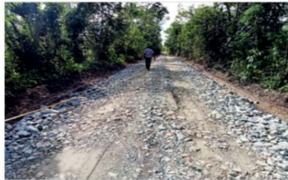
Fotografía: I0187.- Rehabilitación de revestimiento en el Municipio de Macuspana, Ra. Carlos Green 1 era sección.
