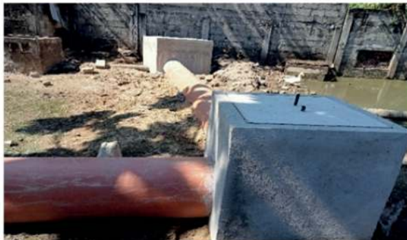
Fotografía: I0161.- Rehabilitación de drenaje sanitario en la calle Carlos Alberto Madrazo de la colonia Belén.
