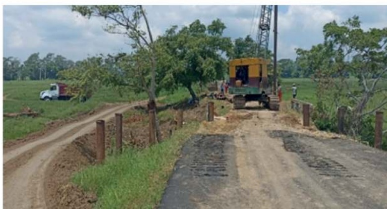
Fotografía: Construcción y rehabilitación de 2 puentes en las comunidades de Unión y liberta y Ra. Alto Tulijá (Chinal).
